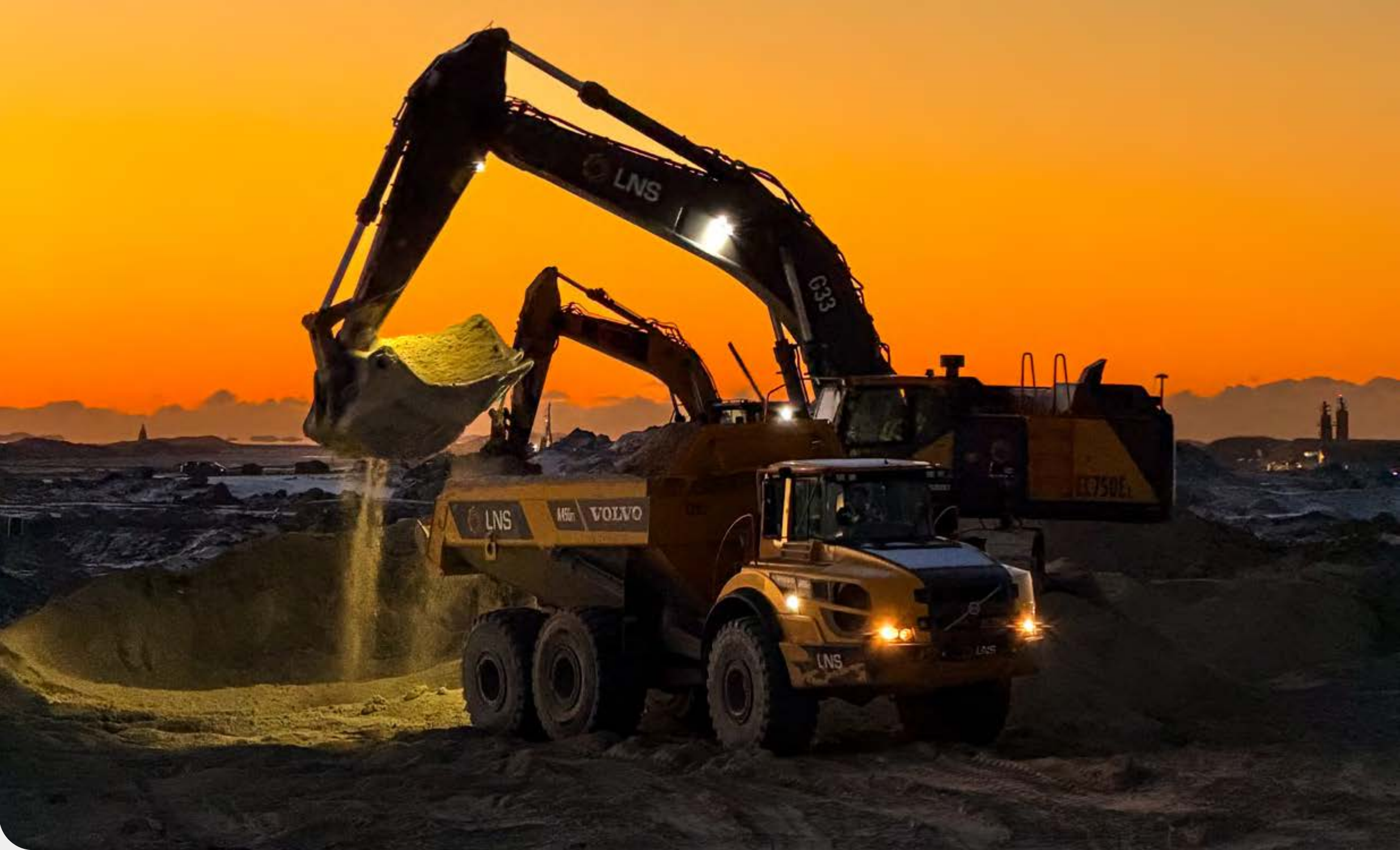
LNS i arbeid ved Bodø Nye Lufthavn
