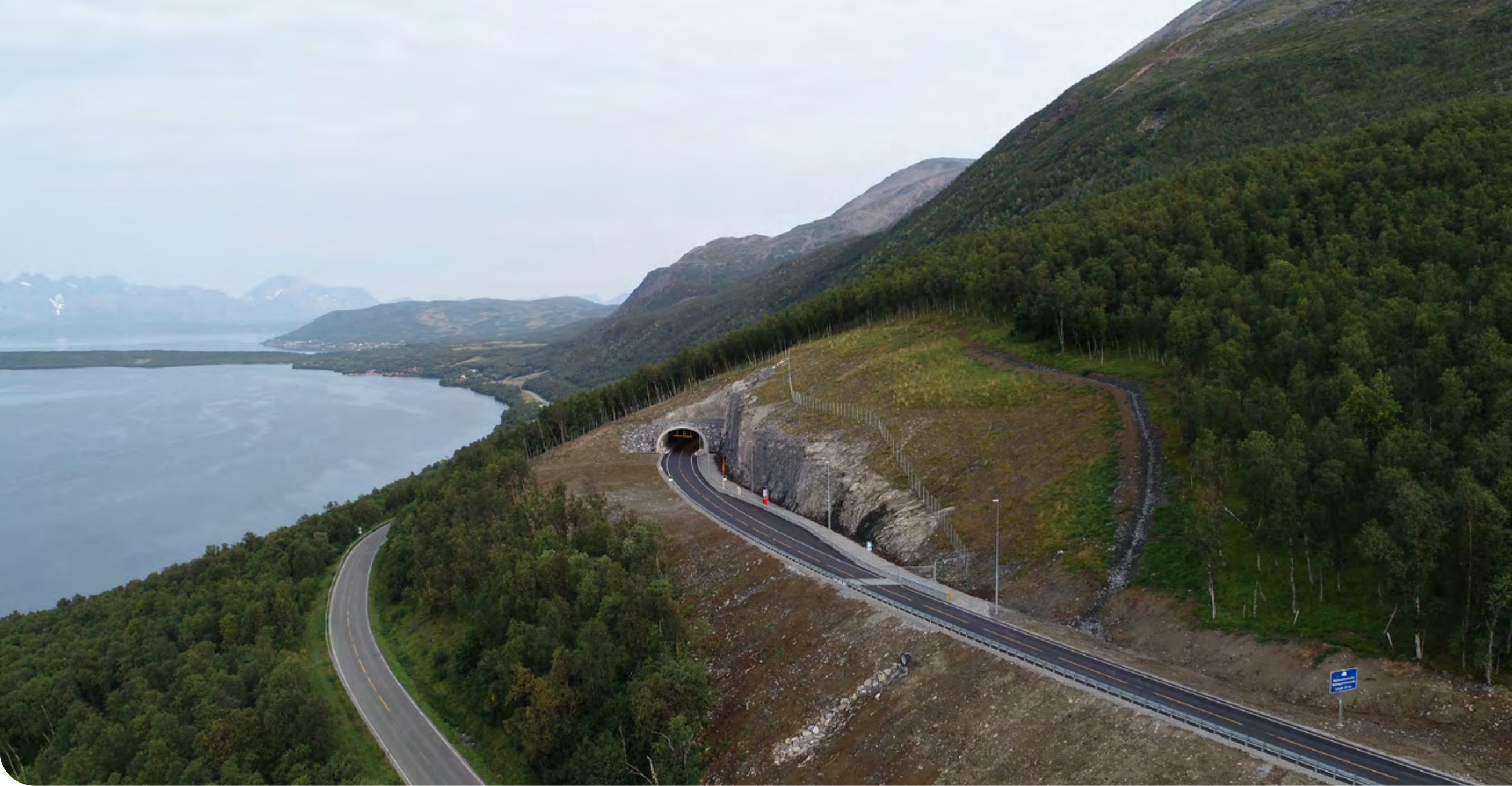
E6 Kvæangsfjellet, Mettevoltunnelen.
